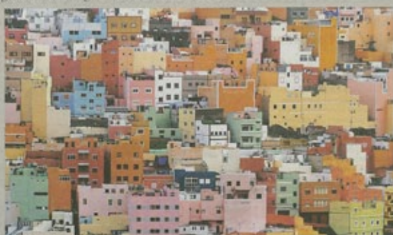
Vista del barrio de San Juan, en la capital grancañaria. LA PROVINCIA-DLP
